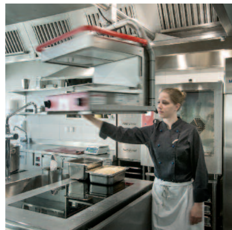
Durchdachte Strukturierung der Kücheneinrichtungen: An den einzelnen Arbeitsposten befinden sich Kühl- und Tiefkühlleinheiten, und der schwenkbare Salamander über der Herdanlage erleichtert das Handling.
